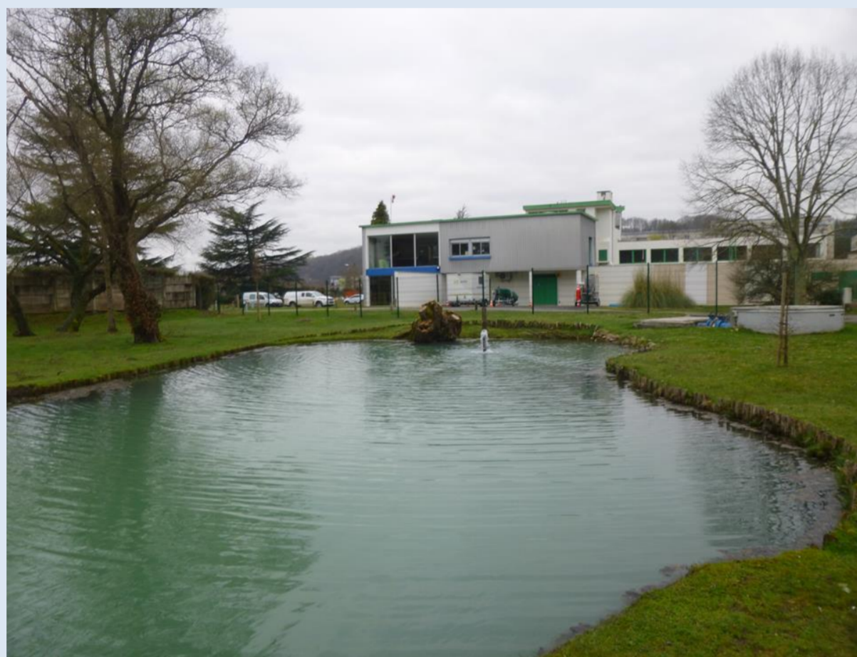
Figure 1 : Source de l'Abîme du Toulon; Pompage et station de traitement au second plan
